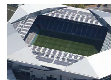
屋根3カ所に設置された太陽電池モジュール 2,100枚で約500kWを発電
