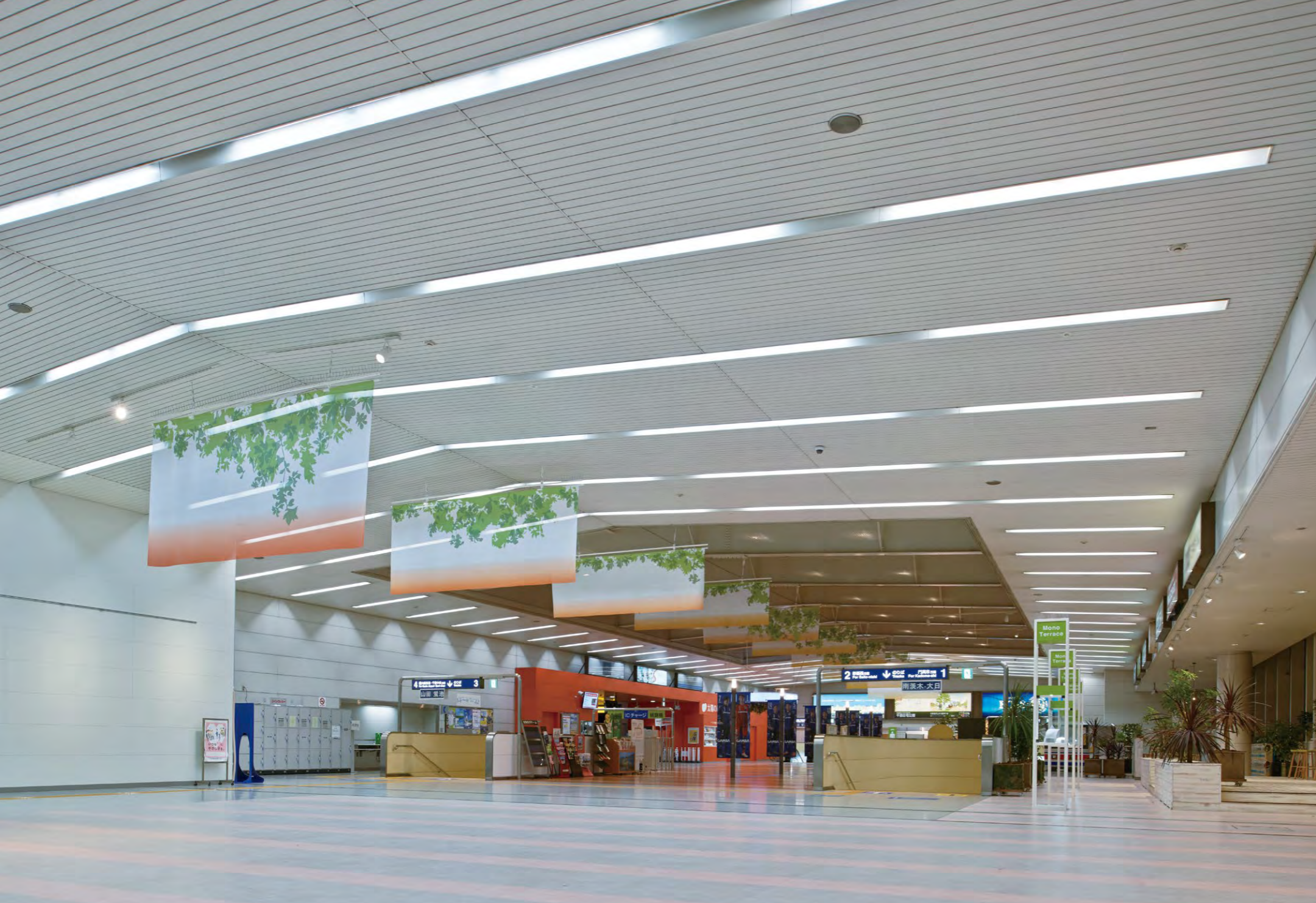
コンコース中央吹き抜けにスポットライトを配置。ベース照明を調光調色することにより時間の移ろいを演出(写真は6時 色温度5000K 照度100%)
