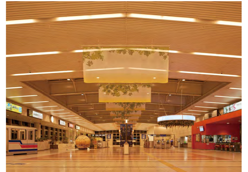
夜のコンコース照明(19時 色温度3000K 照度90%)
