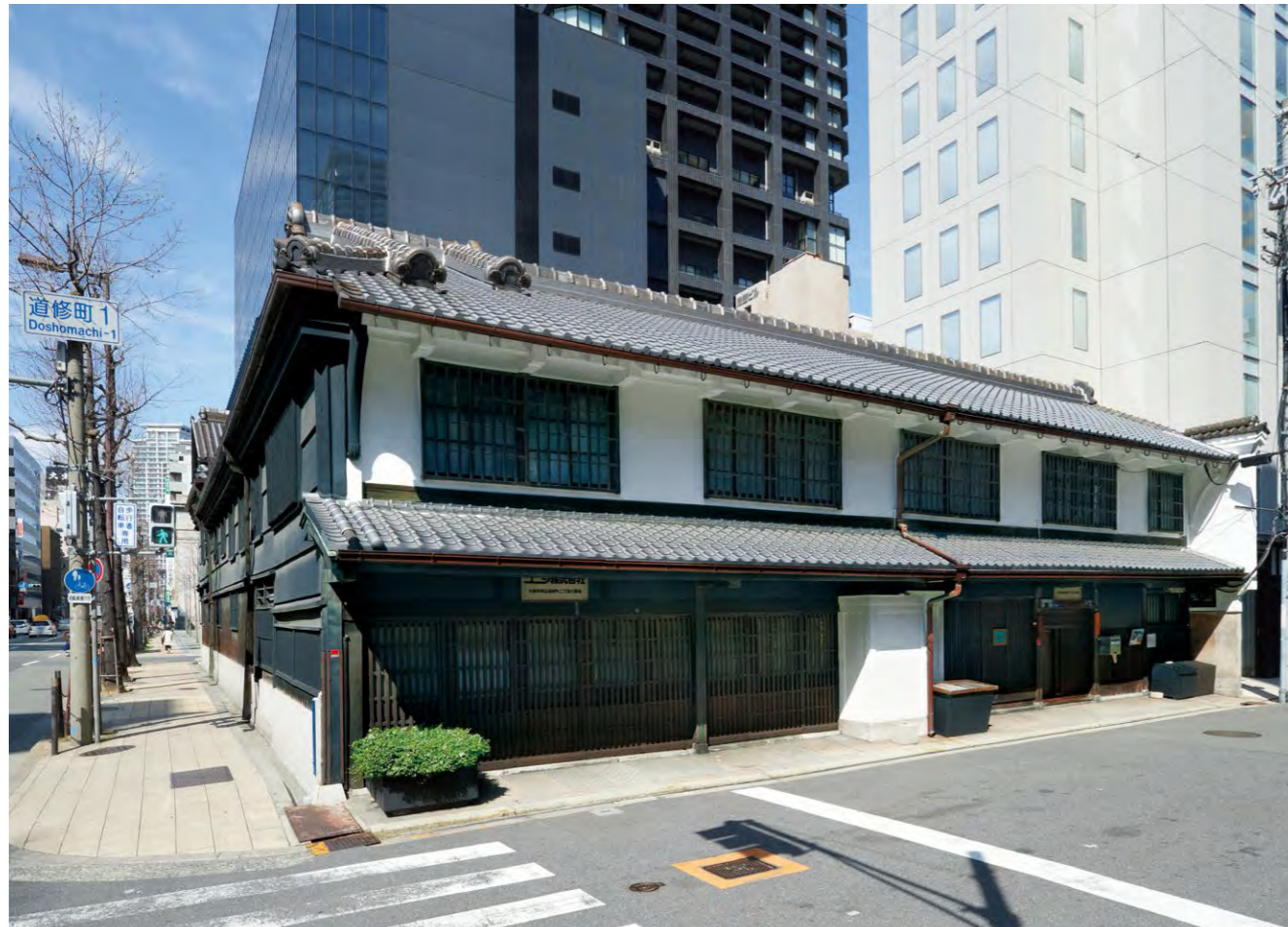
旧小西家住宅は、明治末期における大阪の大商家の屋敷構造を今に伝える貴重な建物である。第二次世界大戦の戦火や阪神淡路大震災の災禍をくぐり抜けてきた。
