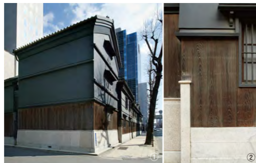
①塀筋に面して建つ衣裳蔵には家財道具を収納した。②居住棟との接続部に非常口があるが、壁面と同じ杉板張りで見立たない。
