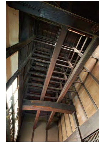
炊事場の煙や湯気がこもらない吹き抜け。小屋組の長大な梁が建物の規模を物語る。
