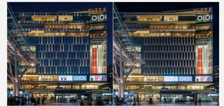
短冊状の壁面を動的に変化させて表情を変えるファサード
