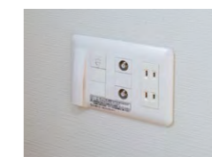
光対応マルチメディアコンセント
