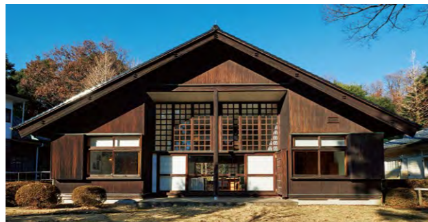
5寸勾配の大きな切妻屋根の下、中央にサロン、左右に小部屋を配するシンメトリの構成。戦時下の資材統制の影響で、丸柱には電信柱を流用したという。
