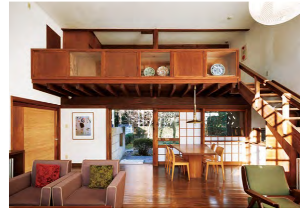
北側中央にも丸柱が立っている。ロフト状の2階は約8畳相当の広さ。飾り棚の鏡板は持ち上げて外す「けんどん式」で、2階から物を出し入れた。
