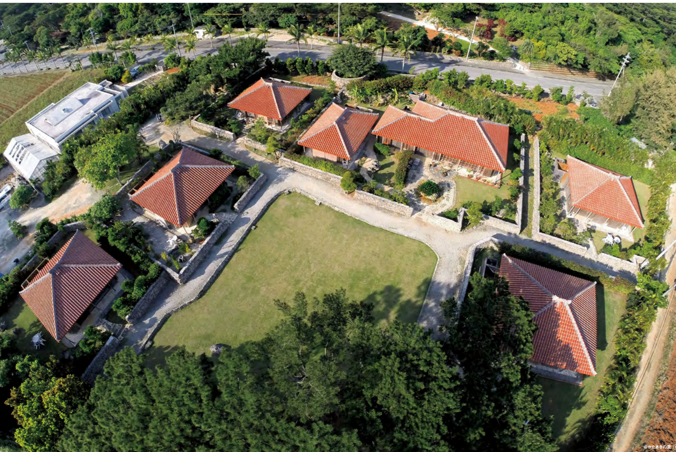
①芝生広場に面して建てられた大小7棟の木造集落体験施設 ②多孔質で表面温度の上がりにくい琉球石灰岩が屋敷を囲う ③室内の熱気を屋根から排出する伝統工法の息道(イチミー)通風口
