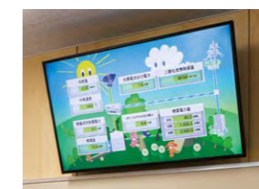
玄関に設置された「見える化」サイネージ
