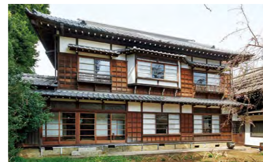
2階出窓や持ち送りがモダンな印象の主屋。当時としては珍しく1階の一部にしか雨戸がないなど、随所に柳のデザインが息づく。
