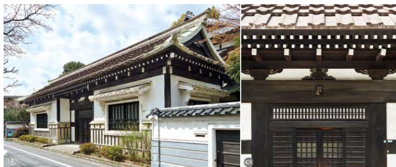
①大谷石の屋根・腰壁が美しい長屋門。柳は石屋根の重厚な造形美を好んだ。門左を応接室、右を妻兼子の音楽室に改装した。②化粧垂木やかえる股など、伝統的な和風の意匠が目立つ。
