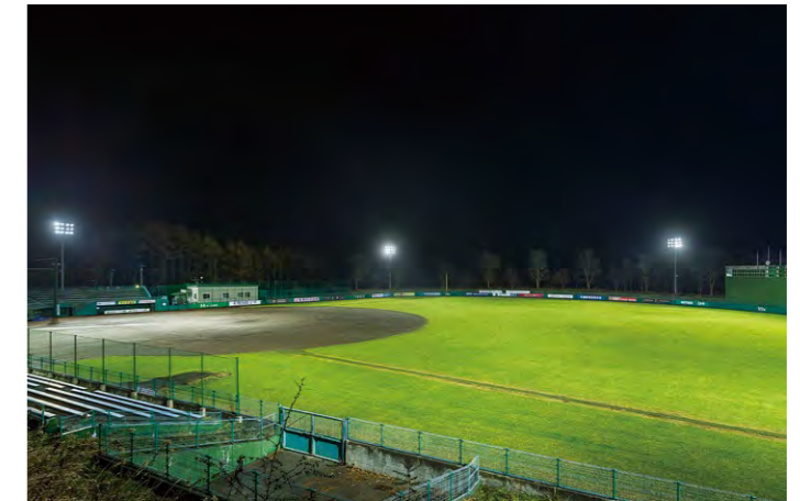
硬式ナイター競技レクリエーションレベルが可能なバッテリー間750 lx、内野500 lx、外野300 lxの平均照度が確保されている
