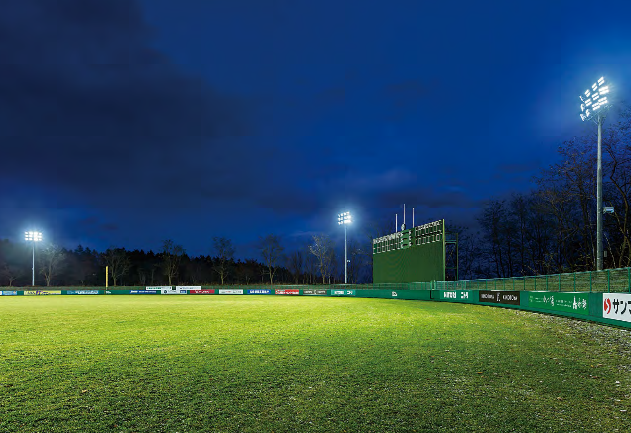
ナイター設備が設けられた両翼99m中堅122mの本格的硬式野球場
