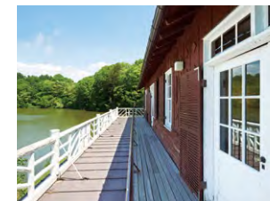
デッキの手摺りは白く塗った丸太を複雑に組み合わせている。
