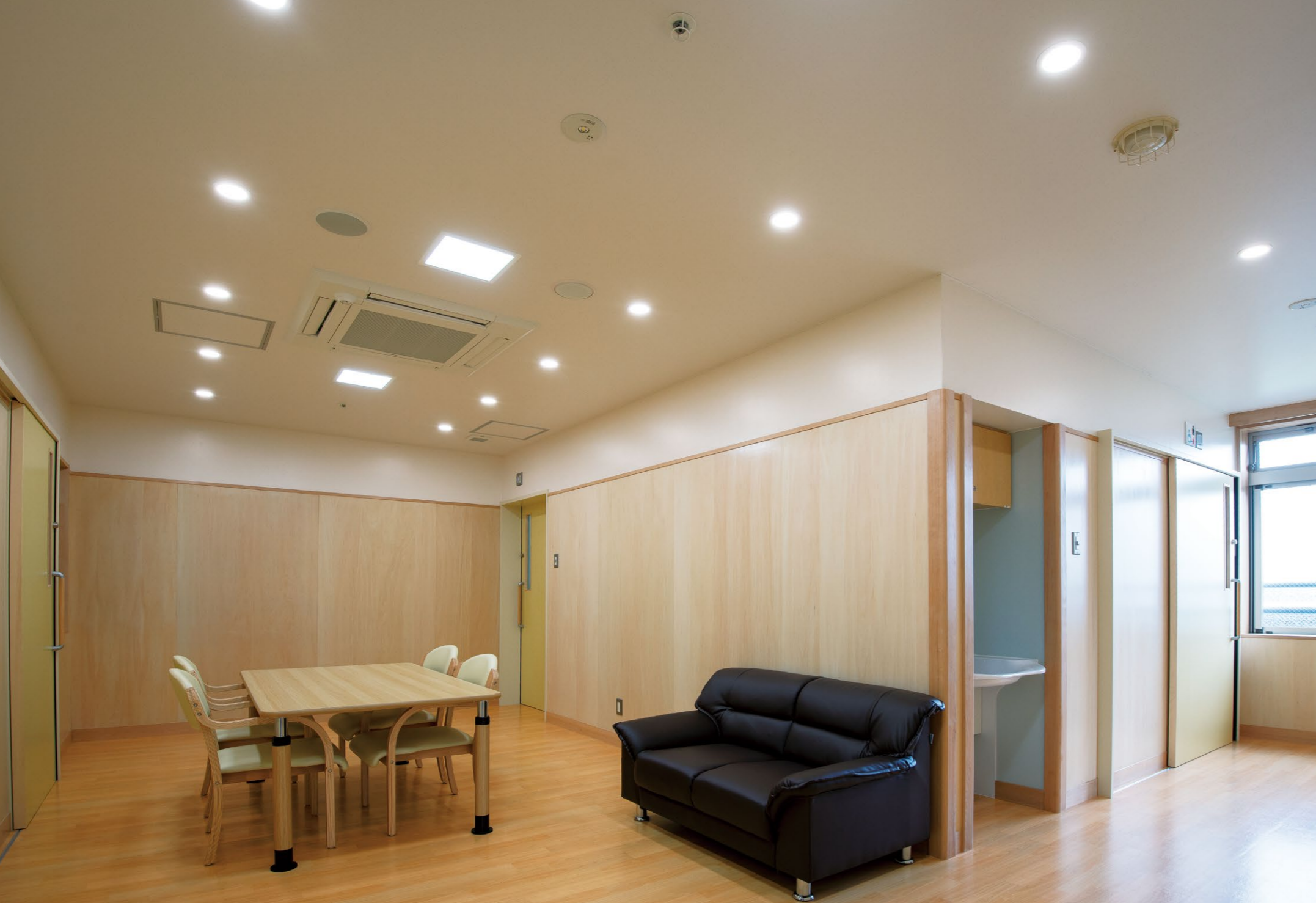
3つの居室に面して設けられたデイルームではスクエアタイプのベースライトに加え、器具の存在感や眩しさを抑えた「スマートアーキ ソフトライト」が採用されている
