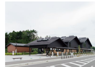
高台に開発された野蒜ヶ丘の野蒜市民センター
