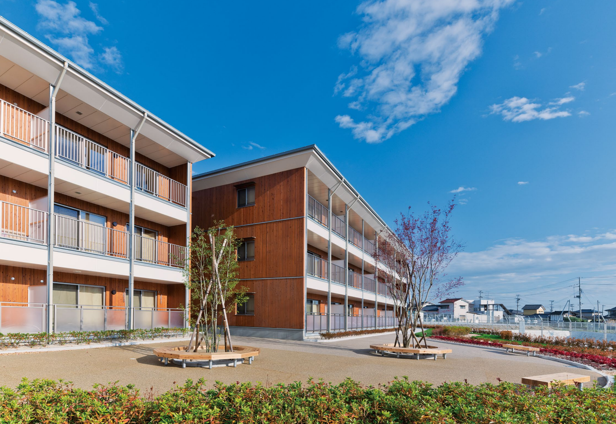
福島県産杉材のWOOD.ALCをカーテンウォールとして用いた復興公営住宅
