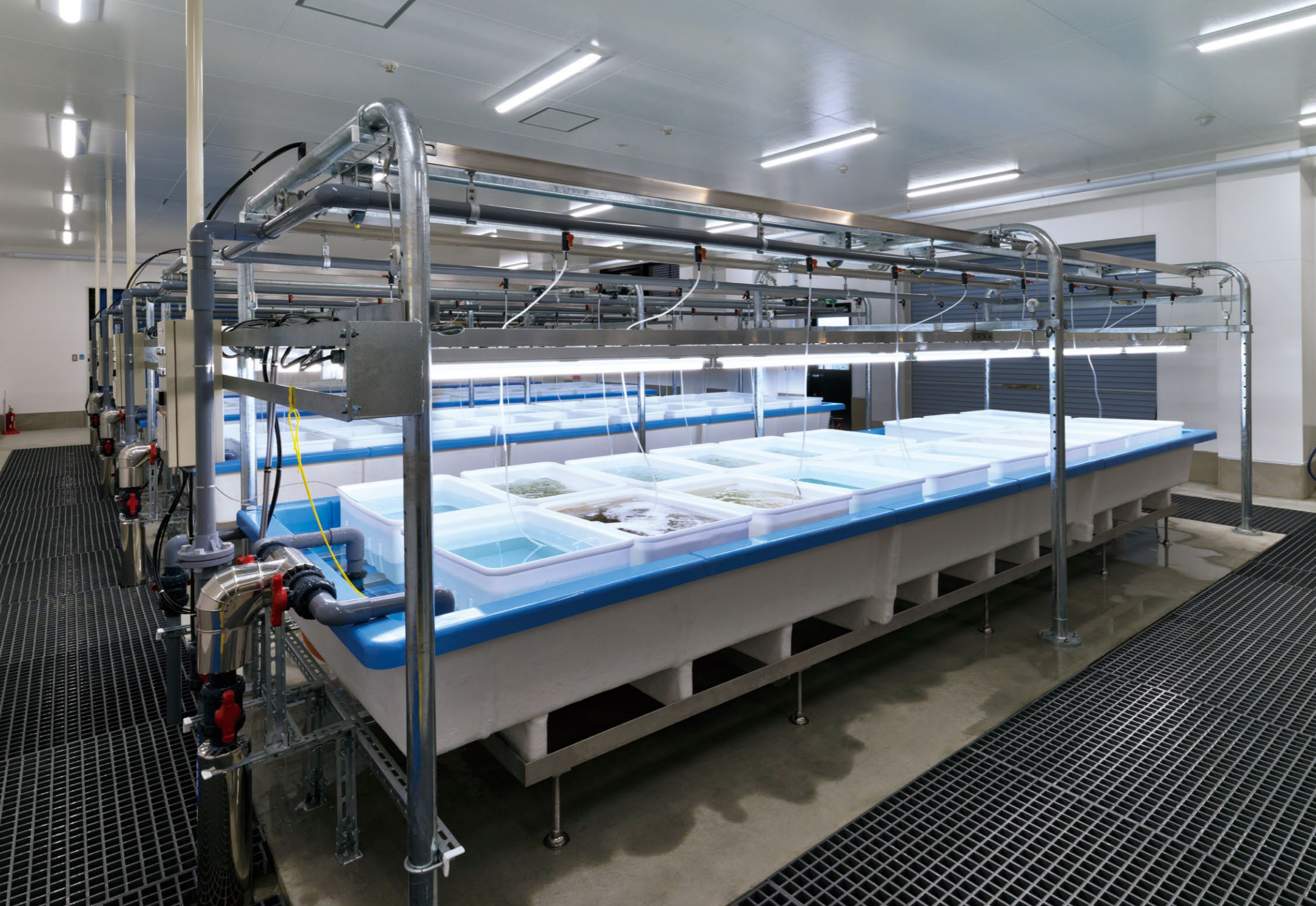
わかめの種苗生育の最適条件を探る種苗室の海水プラント。調光(光色・光量)やスケジュール点灯により、照明環境を自在に変えることができる
