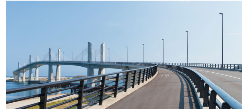
大型船が通航可能な海面高度が確保されたPCエクストラードロード橋
