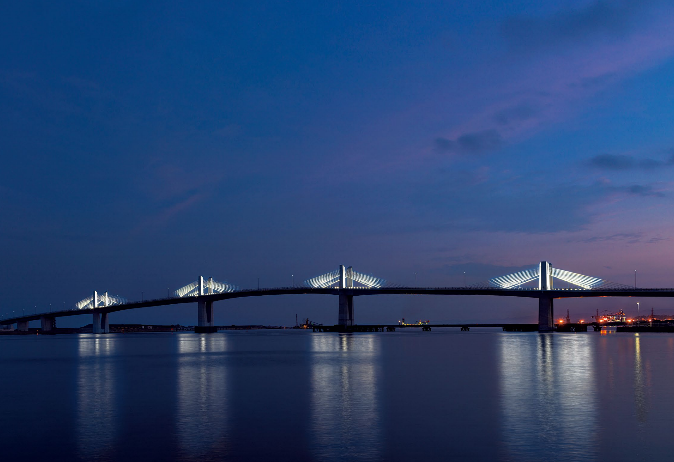
東港地区国際物流ターミナル(写真左)と埠頭を結ぶ小名浜マリブリッジの主塔とケーブルをライトアップ
