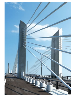
カバーに覆われたライトアップ投光器
