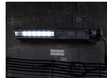
点滅制御で入口部の照るさを確保する入口照明器具
