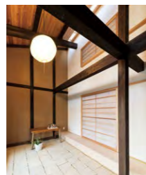
街路に面した土間は断熱障子によってZEHコア部と隔られている
