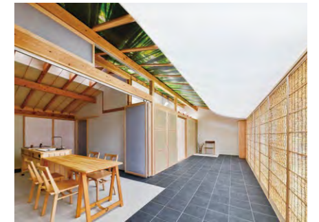
日射量が多い時は天幕や建具で制御する
