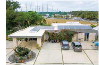
管理棟に設置された太陽電池モジュール「HIT」(右側)
