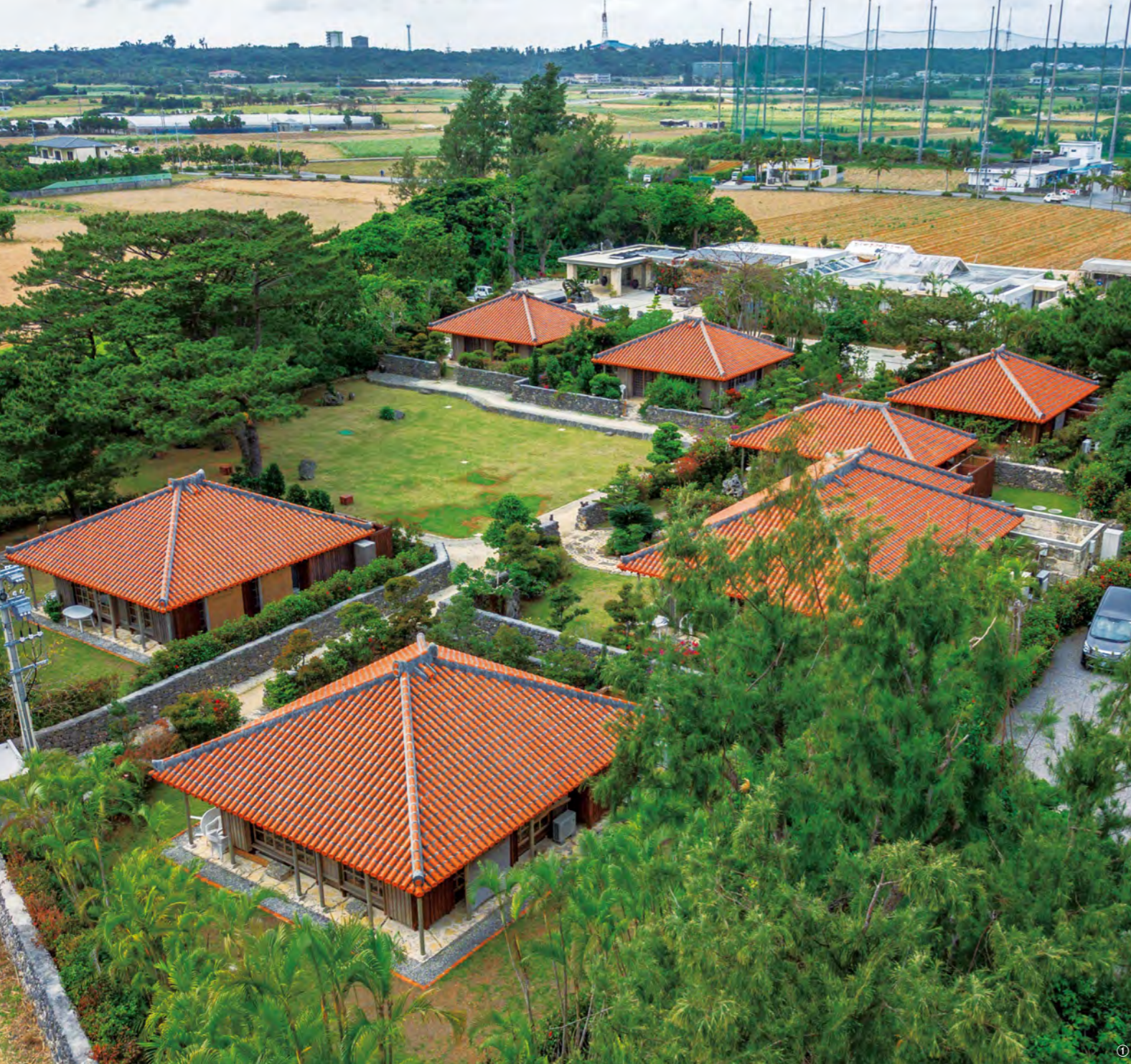
①7棟のコテージからなるかたあきの里 ②③目に付きにくいバックヤードに設置されたエコキュート貯湯タンク ④コテージ内の各種機・コントローラー
