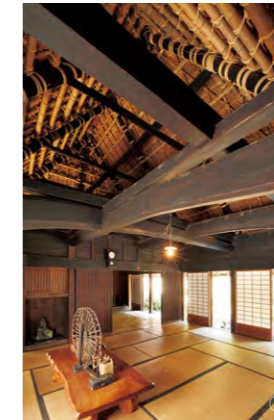
①「おもて」西側の部屋。面取りした梁、竹を組んだ屋根裏が見える。②昭和初期以降には春と秋に畳を上げ養蚕を行った。そのための囲炉裏。
