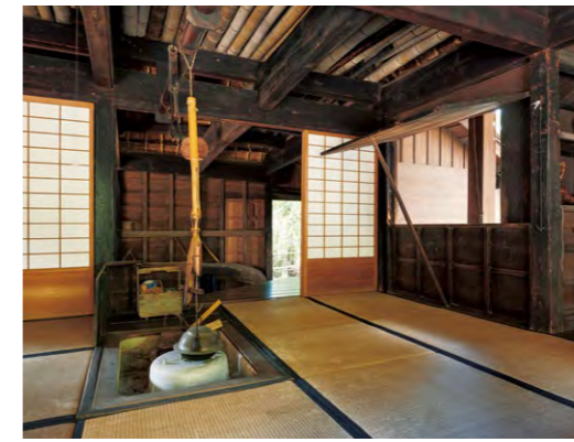
囲炉裏のある「なかえ」は家族の生活の場。2棟がずれて建っているのを利用して、東面に風通し用の藪戸を設けている。
