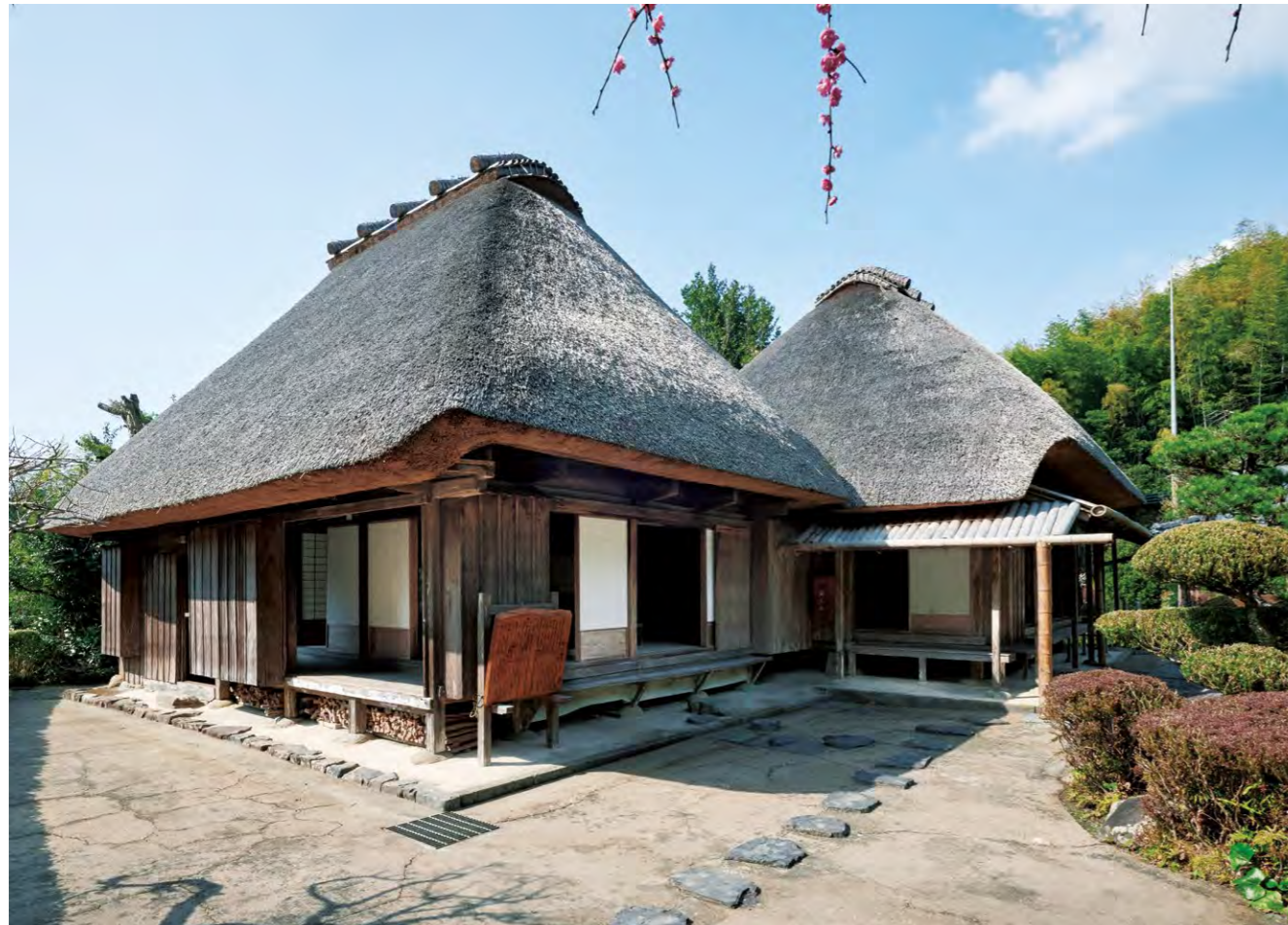
二階堂住宅では軒の方向が異なる茅葺き屋根の建物が接近して建っている。内部に2棟を接続する部屋があり、行き来できる。
