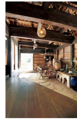
「うすにわ」。板の間を斜めに作ったのは土間を広く取る工夫。
