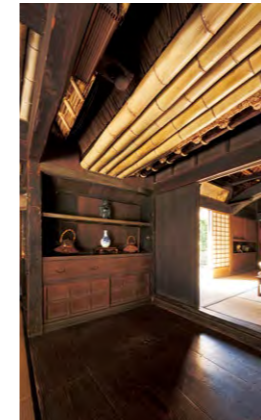
①「といのま」。竹樋の上が2棟の茅葺き屋根の谷。②南側に付き出した樋。③樋に傾斜を付け、北側に雨水を排水。
