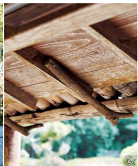
①「おもて」の東、南面には竹葺きの庇が付く。孟宗竹を2つ割りにして節を取って並べ、その上から竹を被せている。②庇の裏から見た竹の樋と木の樋受け。
