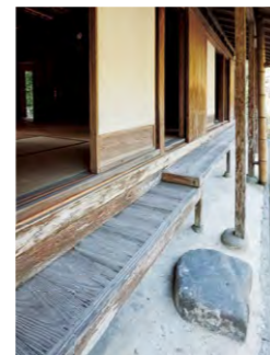
「おもて」の濡れ縁は踏み石のある所で板の張り方を変えている。
