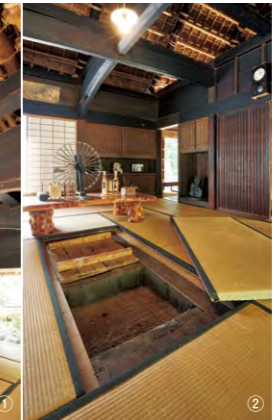
①「おもて」西側の部屋。面取りした梁、竹を組んだ屋根裏が見える。②昭和初期以降には春と秋に畳を上げ養蚕を行った。そのための囲炉裏。
