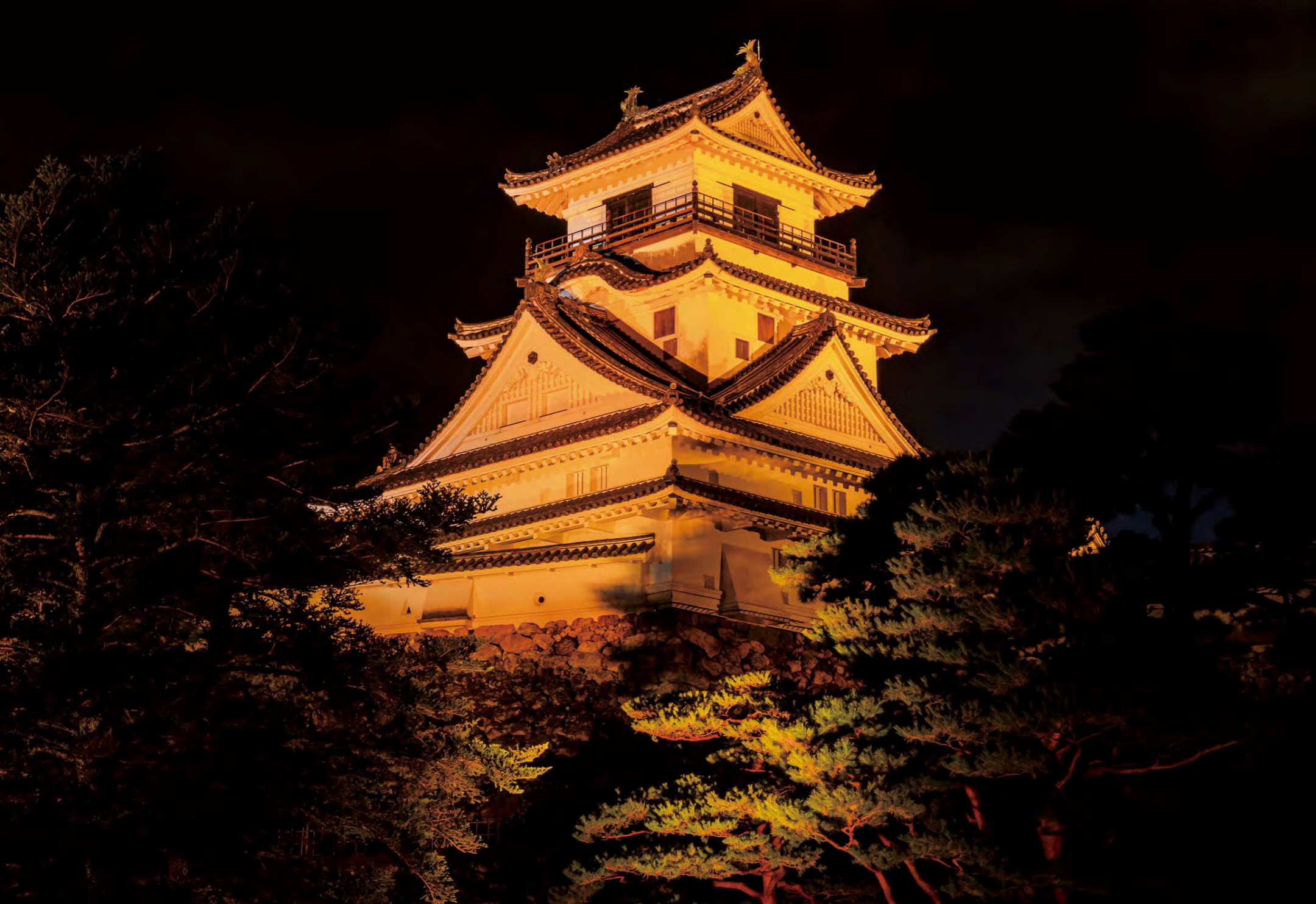
狭角・中角・広角の合計5台の投光器を組み合わせることで、均斉度の高いライトアップが実現されている
