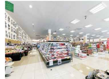
3灯用照明器具を用いたスーパーマーケット
