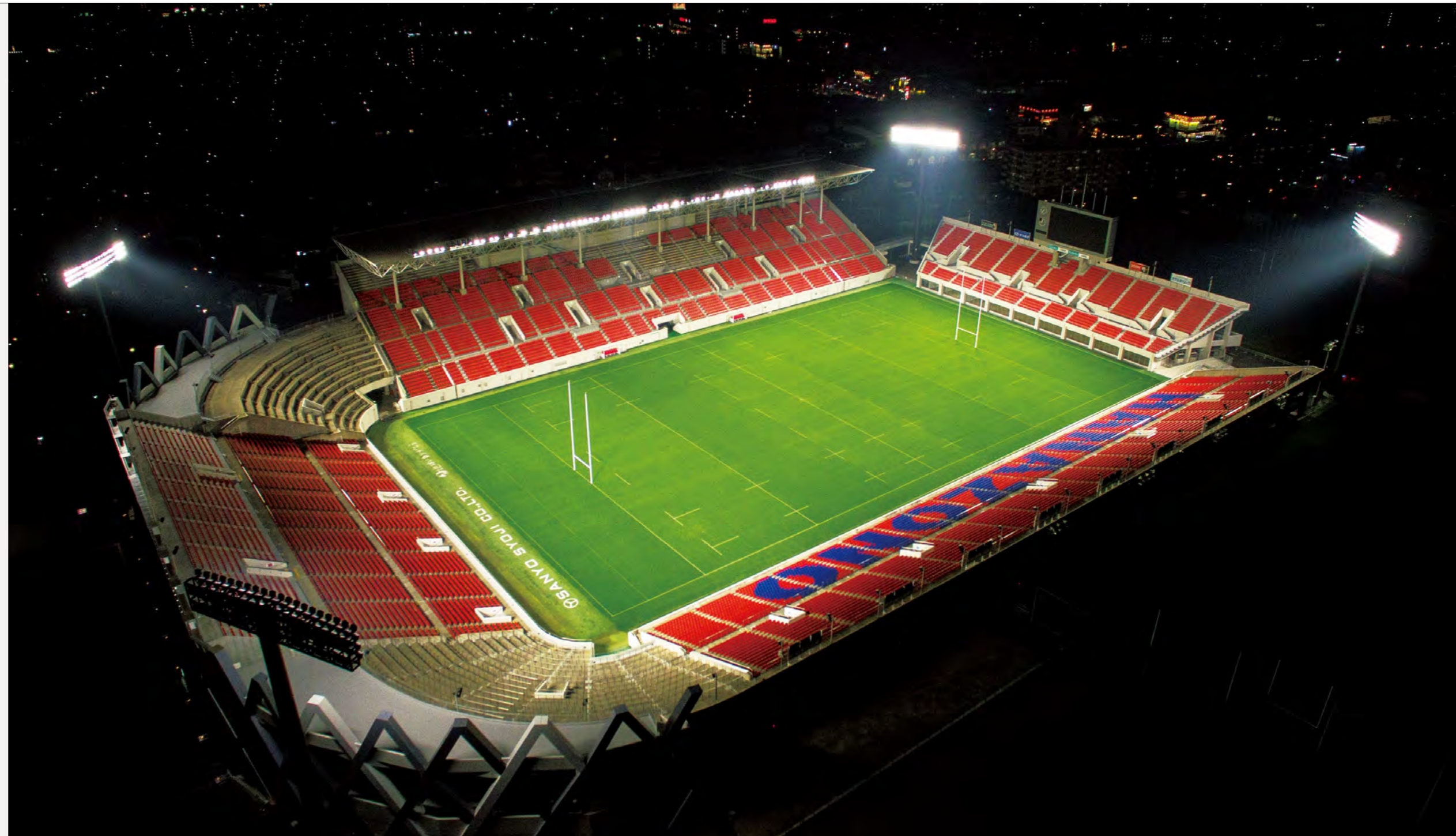
グラウンドの四隅に設けられた照明塔と、メインスタジアム上部に設置された合計381台のLED投光器 (マルチハロゲン灯Sタイプ2000形相当)
