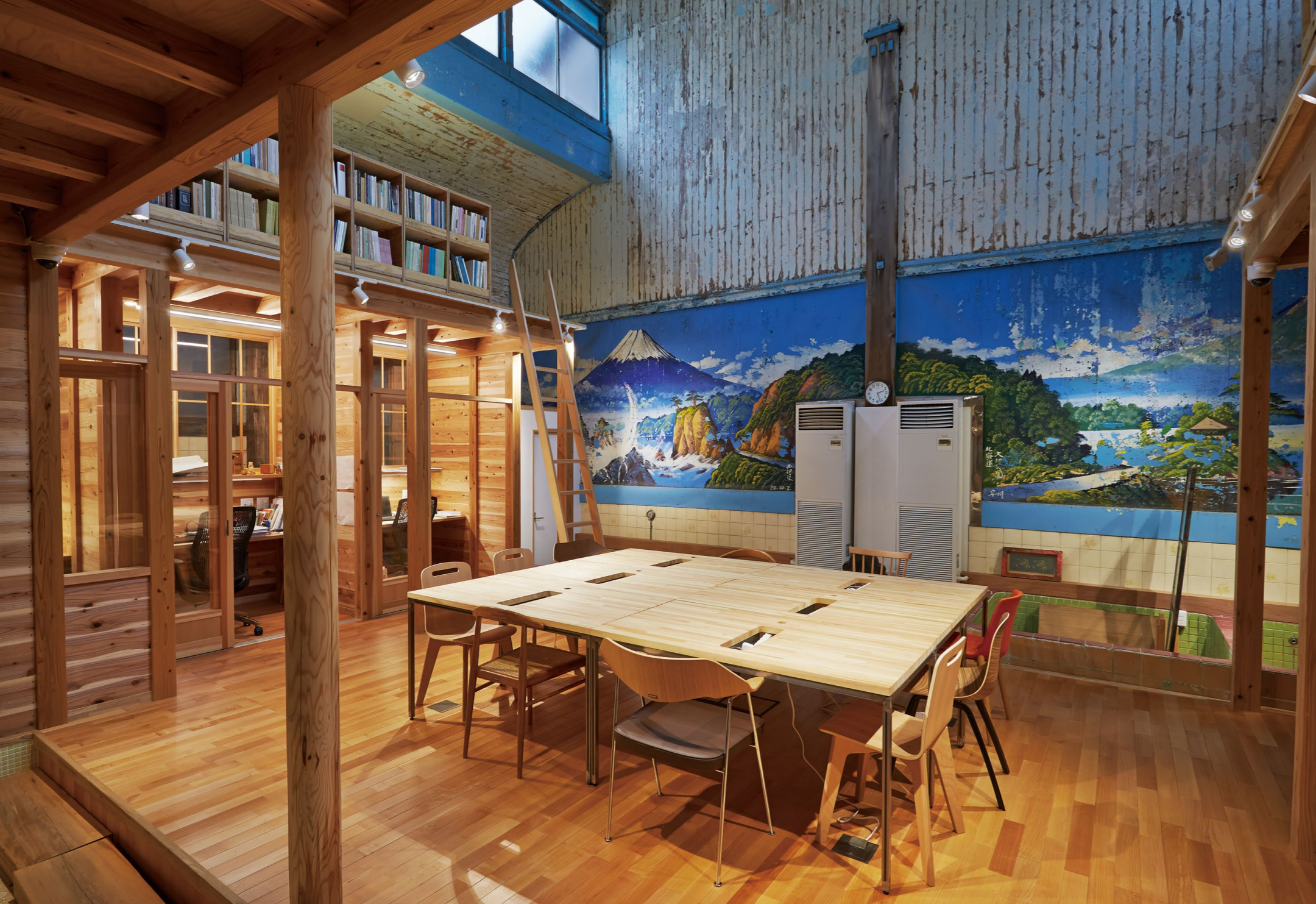
男女浴室の隔壁を取り除き、周囲にオフィススペースを設けることで耐震構造とし、中央部はレンタルスペースとしている
