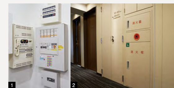
1.コンパクトなアドバンスP-1受信機(右) 2.押しボタンの視認性が高いリング型表示灯付発信機
