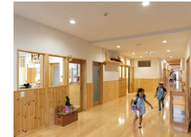
温白色のLEDダウンライトを廊下に設置
