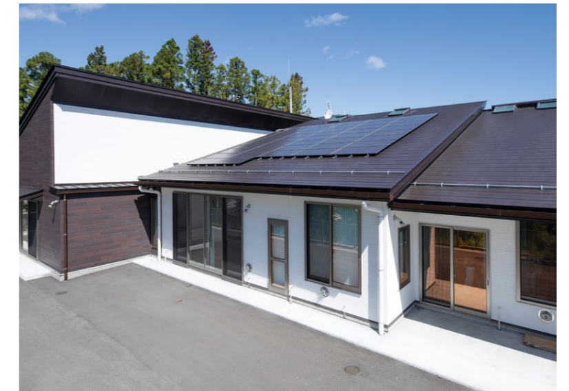
公民館の屋根に設けられた太陽電池モジュールHIT240(10kW)
