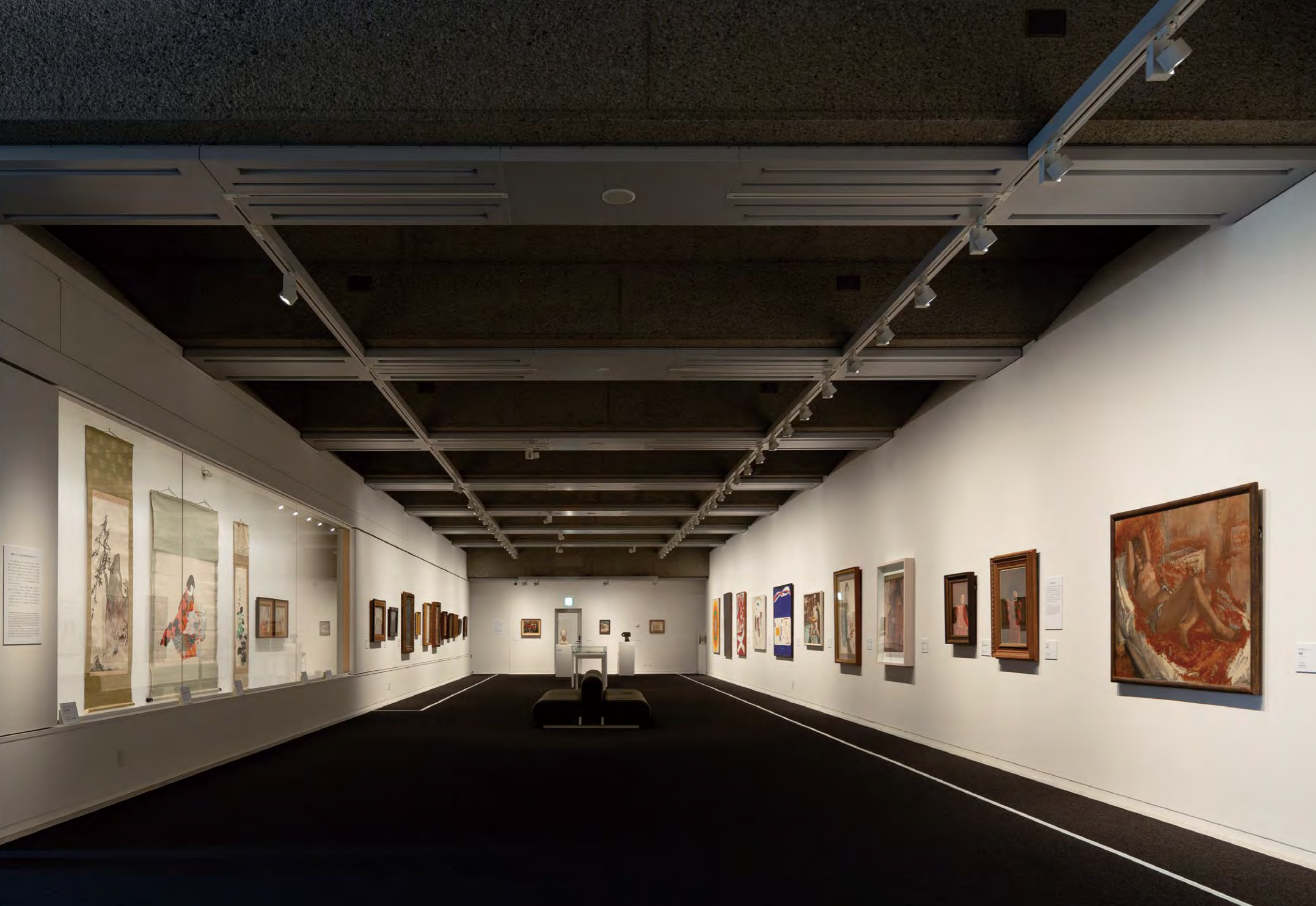
調光・調色機能を備える特注高演色LEDユニットが採用された2階展示室の固定ケース(左)
