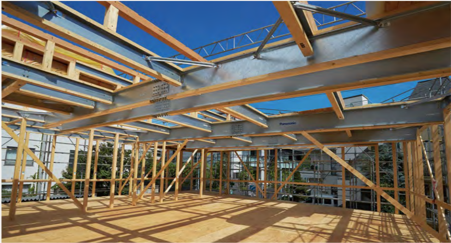
テクノビームが剛接合されている上棟時の2階遊戯室
