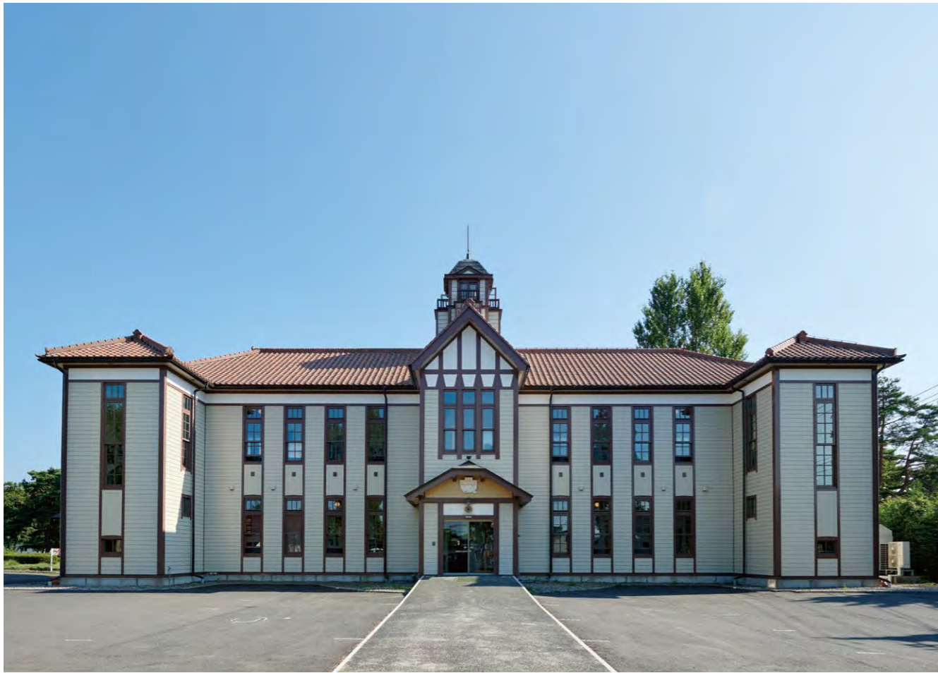
旧緯度観測所本館。2代目の本館として規模を拡充し建設された。ドイツ式の設計で、地元水沢の大工が施工した。小屋組には日本の伝統手法で収めた部分が残る。（奥州市所有）
