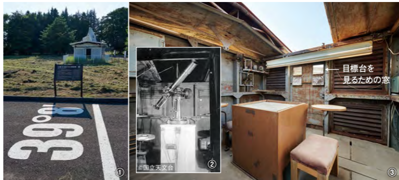
①北緯39°8'上に建つ眼視天頂儀室（写真奥） ②当時の室内。木村がドイツから持ち帰った眼視天頂儀がある。 ③精密に測定するため、壁を鉄製鉛板にして空気を循環。室内外の大気差がないように工夫した。
