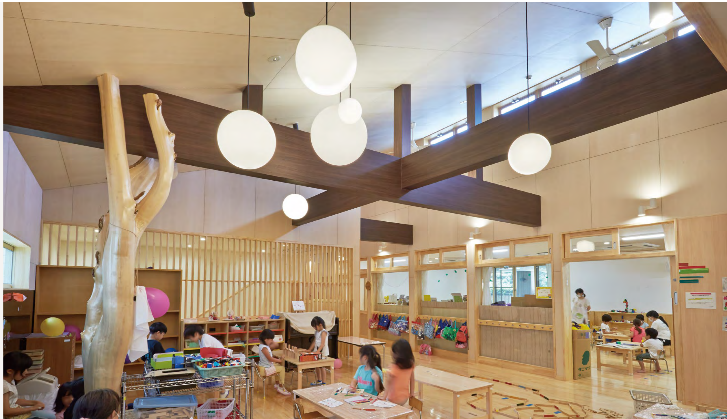
テクノビームの剛接合梁(木化粧)によって実現した奥行7.3mのスパンが確保された2階ホール
