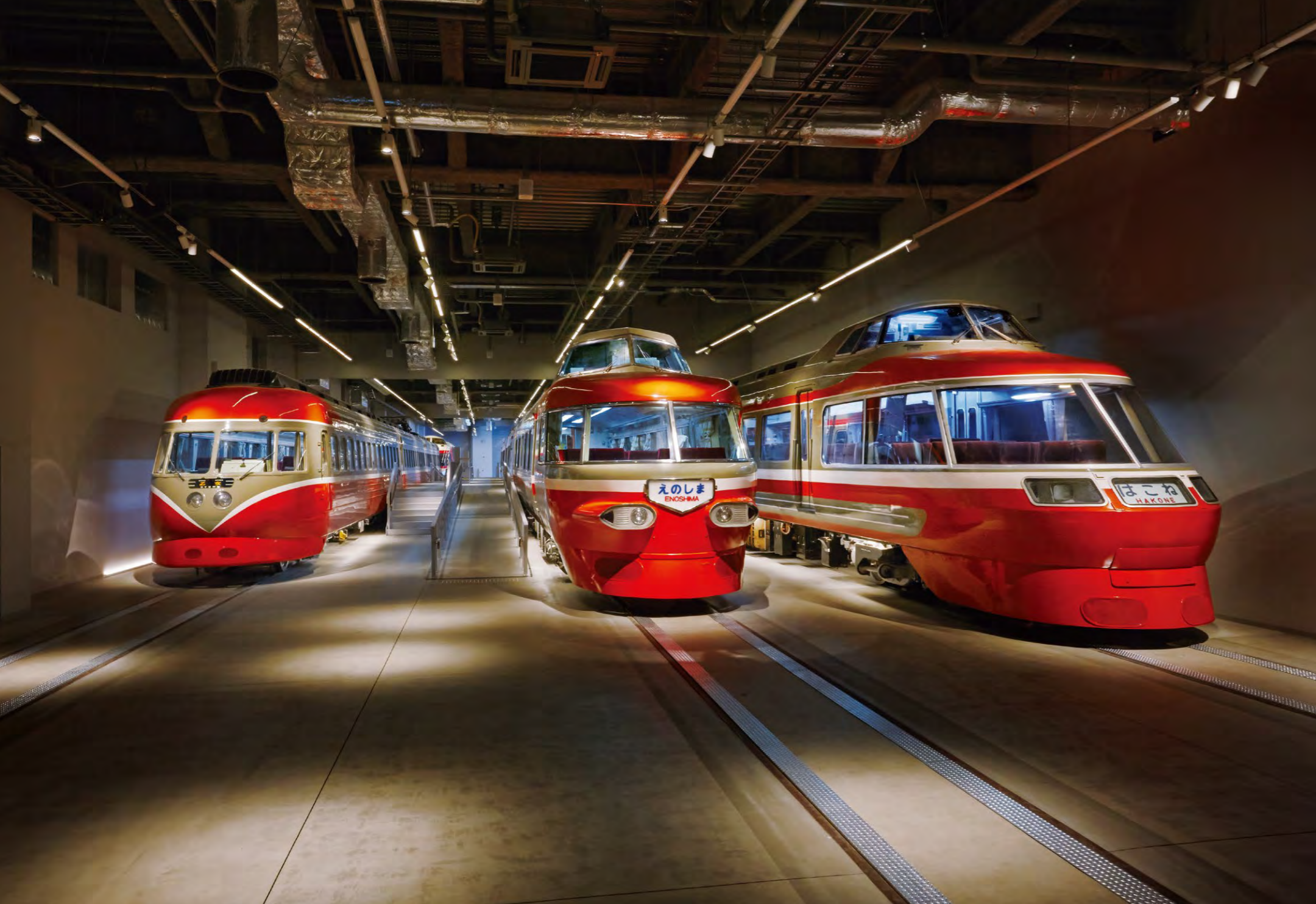
「魅せる検車庫」のコンセプトによる、シンプルな内装の車両展示室。台車にはシームレス建築化照明器具を配置。TOLSO BeAm Freeスポットライトは配光調整ができ、WiLIA無線調光システムによって照度変更が可能
