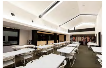
ワークショップに利用される「離宮ホール」に設けられたシームレス建築化照明
