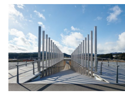
床版や高欄支柱には南三陸町産杉材が使われている
