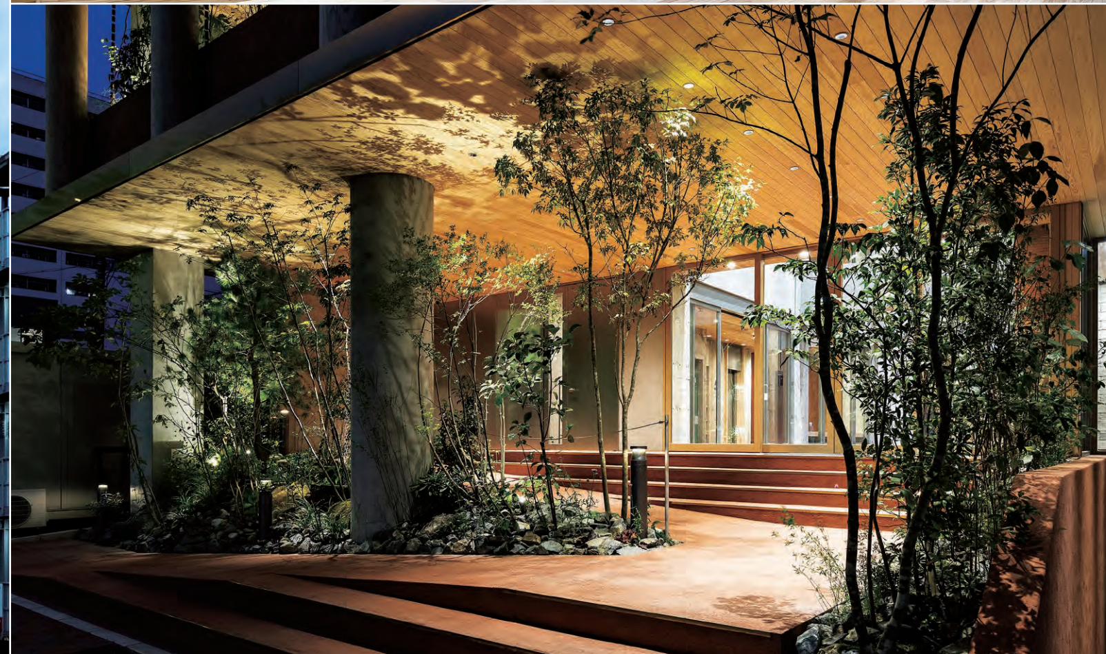
(左) 執務室などから漏れる光でバルコニーを照らすとともに、各フロアバルコニー両端にアップライトを設置して1本の吉野杉が貫通する情景を創り出している (右上) 日没後は照度確保が難しいため、8階ホールではトップライト梁部にスポットライトを設置 (右下) 風除室につながる底にΦ75のグレアレスダウンライトを均等に配置し、スロープにはアクセントとしてガーデンライトを設置している
