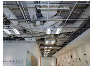
感染症対策検討により大幅に増設された 換気用ダクト
