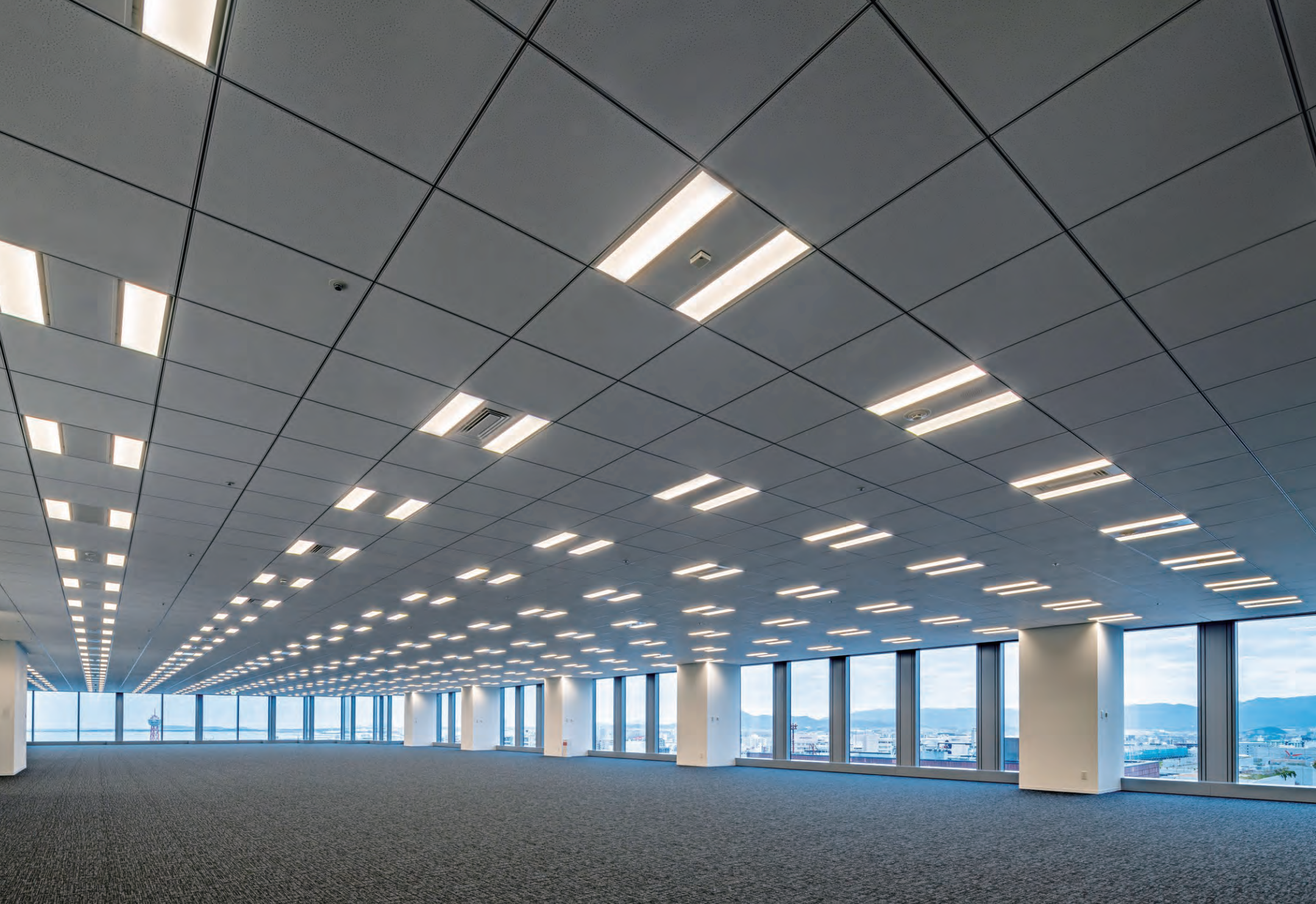
基準階貸床面積は約2,370m 2 (写真は16階)。システム天井には白色 (色温度4000K) の一体型LEDベースライト フラットパネルタイプが採用された
