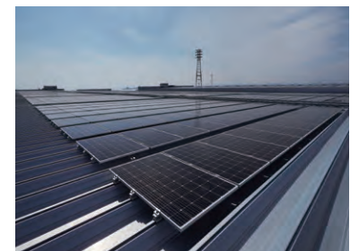
屋上に設置された約1MWの太陽電池モジュール
