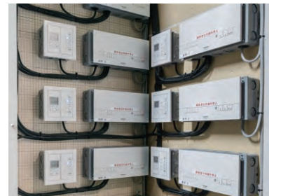
各階のEPSに設置された ライトマネージャー Fx
