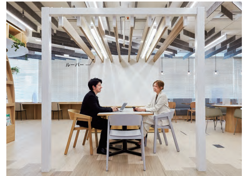
ルーバーから流れる空気が下方向の均一な面 airflow を発生させることでエアロゾルを床に落とす 「エアリーソリューション」
