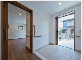
車いすが回転できるように直径1.5mが確保された玄関
