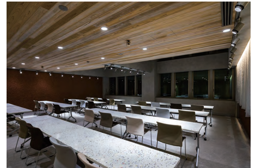
既存スラブ南側を除去し、天井を南に向かって反り上げることで冬の日射を取り込む7階会議室
