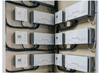
各階のEPSに設置されたライトマネージャー Fx
