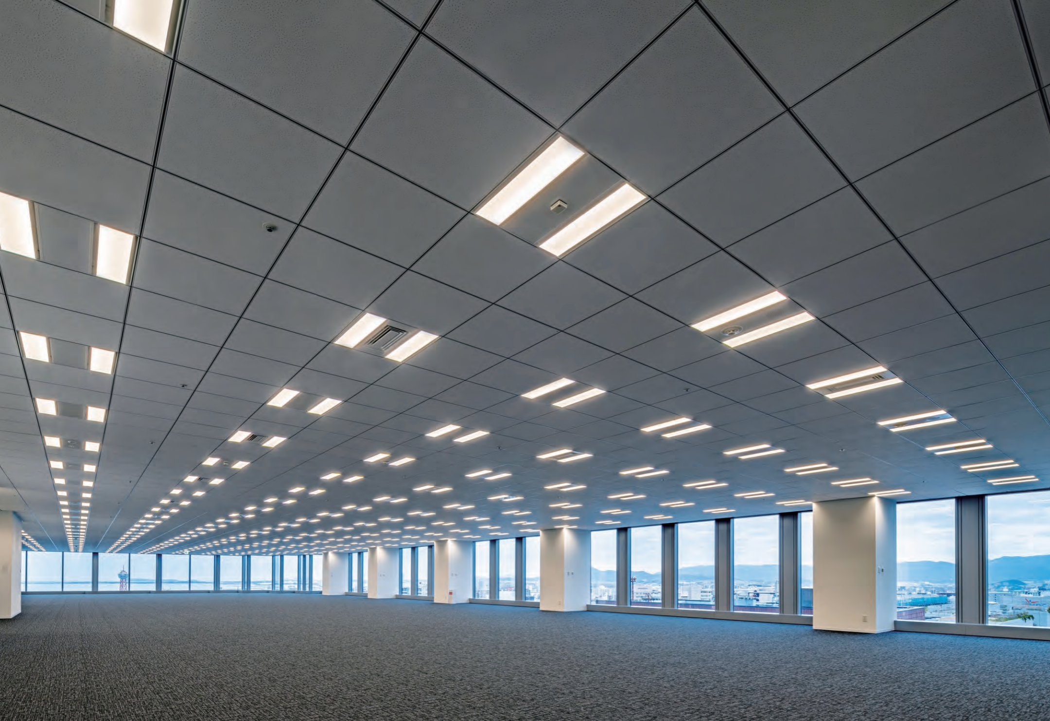
基準階貸床面積は約2,370㎡(写真は16階)。システム天井には白色(色温度4000K)の一体型LEDベースライト フラットパネルタイプが採用された
