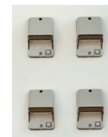
システムの停電時にも利用できる 非常用コンセント
