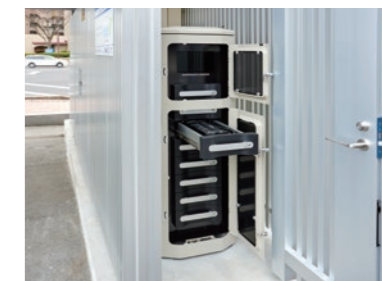
小型モビリティ用ポータブル蓄電ユニット(8kWh) (AZAPA社の実証実験機)
