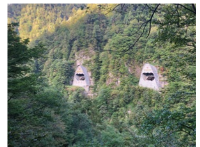
唯一、外部に露出している送電線引出口。主に関西方面に送電し、約30万世帯の電気をまかなう。
