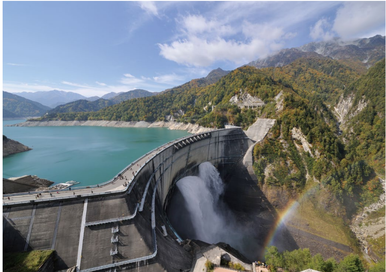
北アルプスを背景に威容を誇る黒部ダム。堤高は日本一。毎年6/26～10/15には毎秒10m 3 以上の水を、直下の岩盤保護のため霧状にして観光放水する。
