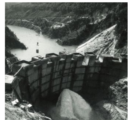
コンクリート打設中のダム。昭和35年10月に湛水を開始。翌年1月には一部営業運転を始め、電力需給に貢献した。
