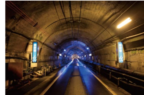
くろよん建設最大の難所であった破碎帯を突破し、昭和33年に開通した関電トンネル。現在は観光ルートの一部になっている。
