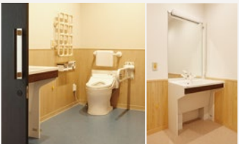
左麻痺、右麻痺の利用者に配慮し、トイレや「アクアハート洗面」の配置を工夫した車いす用トイレ
