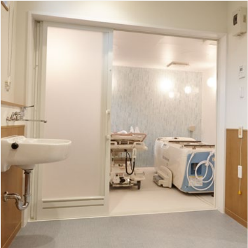
重度化対応が可能な特浴用ユニットバスに機械浴を配置。浴室内の段差0mm（高低差3mm）でキャリーなどの移動もスムーズ
