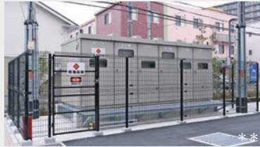
エリア一括受電だからこそ可能な常用線と予備線の 2回線引込により、まちとして停電時のリスクを軽減
