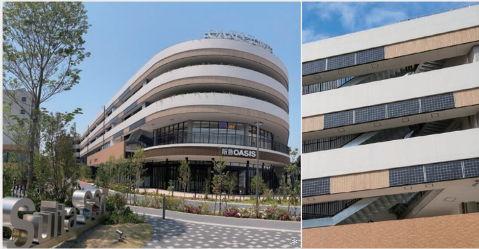
複合商業施設「オアシスタウン吹田SST」(左)と壁面に設置された太陽電池モジュール(右)
