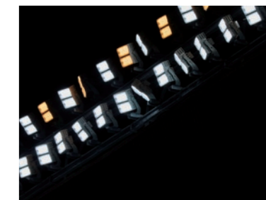
グレアを低減するよう綿密に角度調節された銀傘上に設置された投光器
