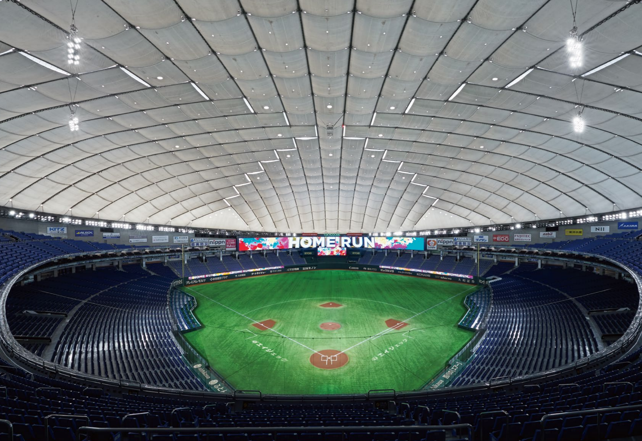
DMX制御されたドーム内周のLED投光器と、ポールから外野フェンス上部に設置された2面のリボンビジョン
