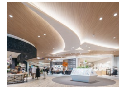
1階オーバールパーク エントランスに設置された建築化照明とダウンライト
