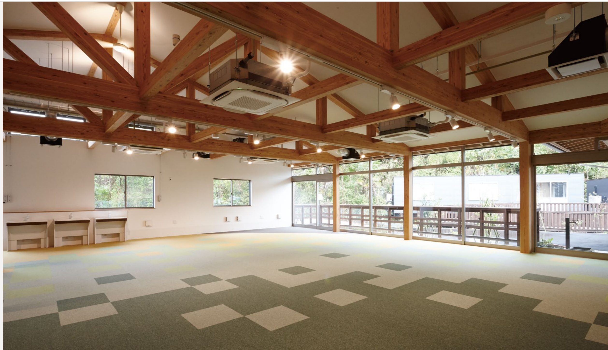
大開口の窓や現しの小屋組を採用し、広々として快適な空間となった生活介護活動室。車いすで使いやすい「アクアハート洗面」(左)も設置
