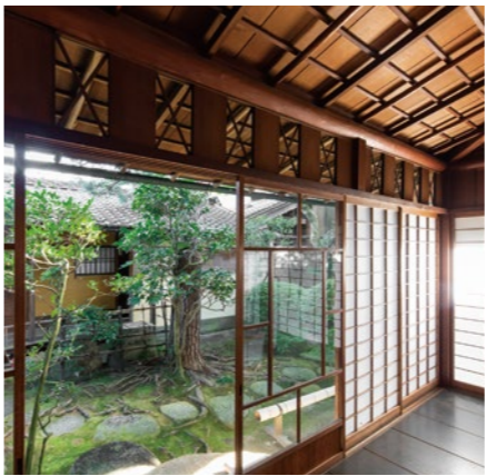
大正座敷の広縁。杉磨き丸太の桁は約18mもの長材。小窓に無双窓をあしらい、天井は化粧根裏とする。
