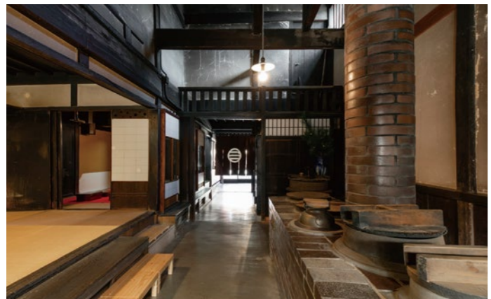
江戸中期に建てられた主屋主体部。幅2間、奥行き8間の通り土間の左には使用人が食事した台所や、店の間がある。右に見えるカマドは明治期に特注の耐火レンガで作られた。
