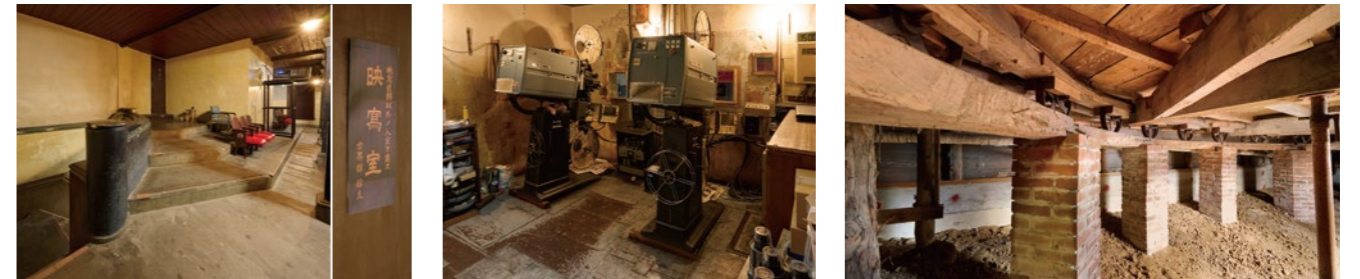
階段室から見た2階映写室(中央奥)。光量が少ない古い映写機時代は1階に映写室があった。50年以上、繰り返し修理して使われている35ミリフィルム映写機。随時、フィルム上映会も実施する。奈落に残る回り舞台の装置。円形に切り込まれた舞台を回すためのたくさんの車輪とレール、それらを支えるレンガの柱が見える。
