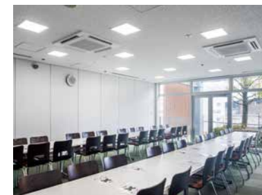
一部フロアでは省エネ性能の高い4方向天井カセット形のエアコンを導入
