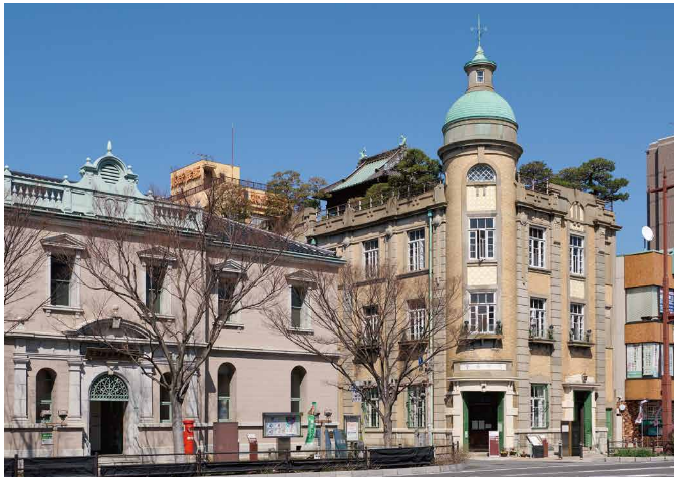
ドームを頂く塔屋が目を引き旧秋田商会ビル。当時の最新技術だった鉄筋コンクリート造の洋館に事務所、和風の住居・接客空間を階別に配置するユニークな造り。屋上に瓦葺きの離れ座敷と庭園の植栽が見える。
