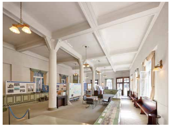
1階事務所は洋風の造作。梁と4本の独立柱はC・I形鋼と鉄筋コンクリートで造られている。柱の持ち送り、上の鉄骨を支える部材を装飾的にしたもの。
