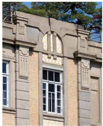
化粧タイルを貼った外壁。付け柱の柱頭とパラペットにセセッション風の幾何学模様がある。
