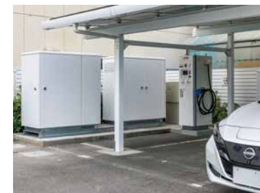
通常は最大5台に急速充電し、非常時にはEVから電力を供給するV2Xシステム
