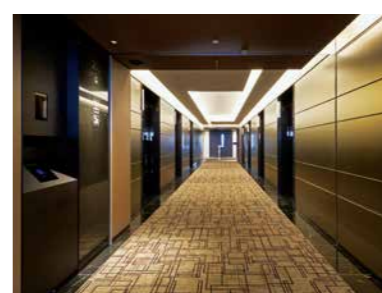
基準階エレベーターホールの建築化照明
