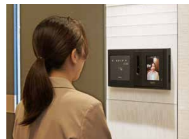
基準階執務室に設置された顔認証システム
