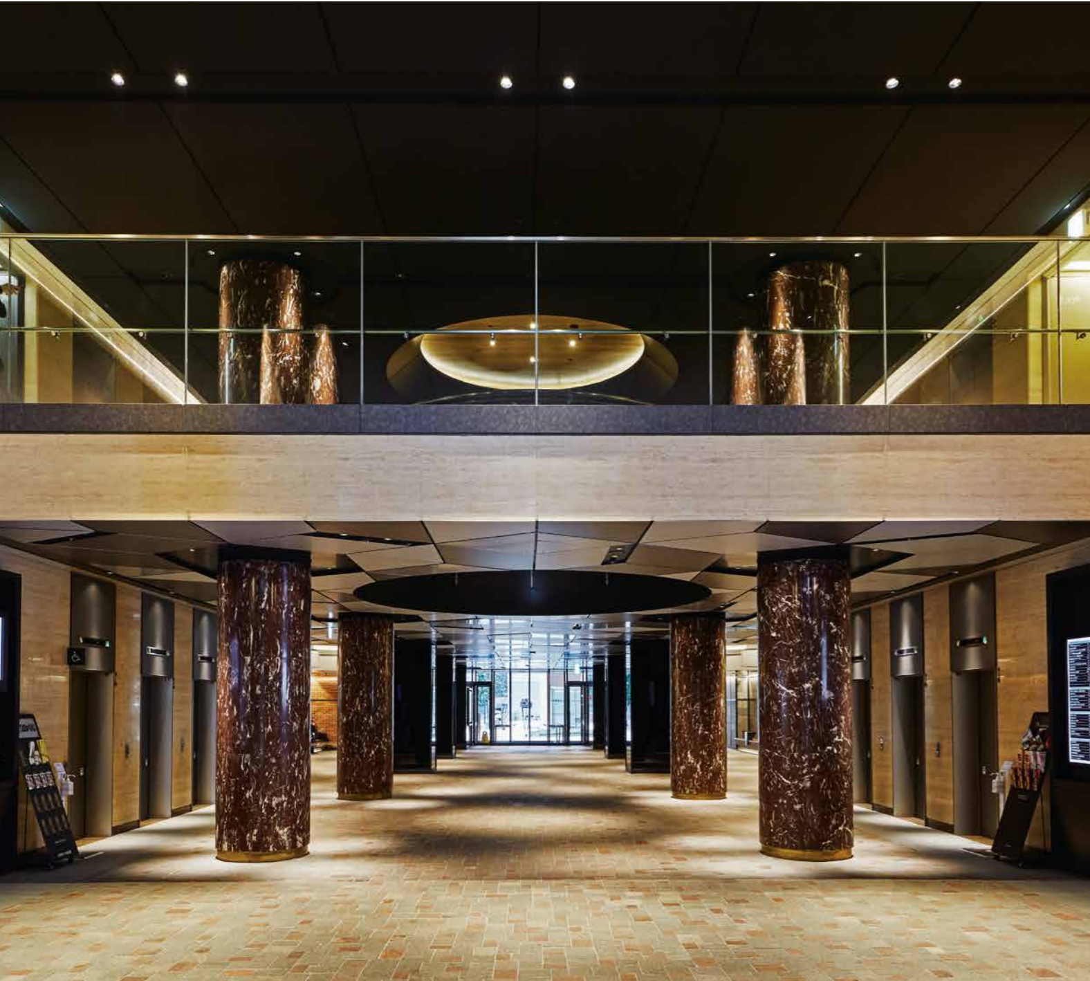
仲通りから連続し、建物1階中央部を南北に貫く長さ約50mのメインエントランス通路。床面は仲通りなどで用いられているアルゼンチン斑岩が敷設されている
