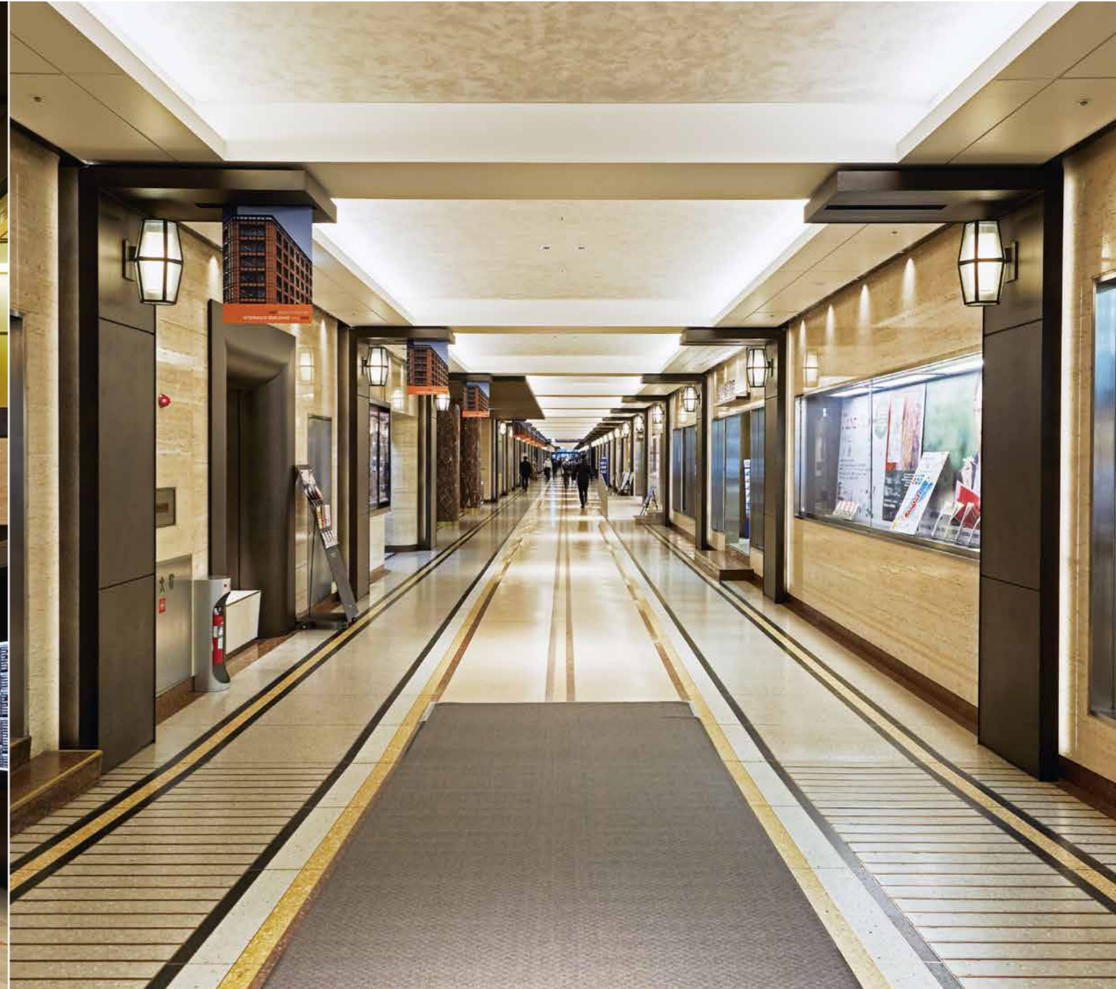
建物1階を東西に貫通する約200mの通路では、天井の建築化照明により地明かりが確保されている
