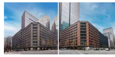
西側ファサード 東側ファサード
