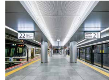
地下ホームのフルスクリーンタイプのホームドアとグレアを感じさせない中央の建築化照明
