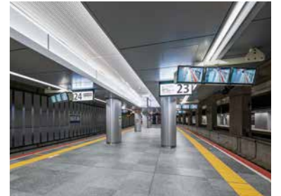
乗降客の足を照らす黄色い点字ブロック上のライン照明
