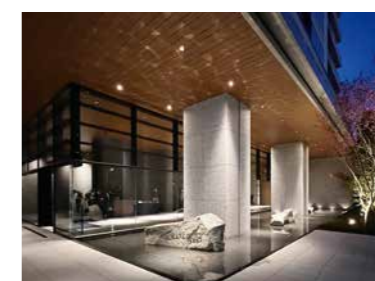
東棟エントランスでは水盤へのカスタムダウンライトが揺らぐ水面を軒下に映す
