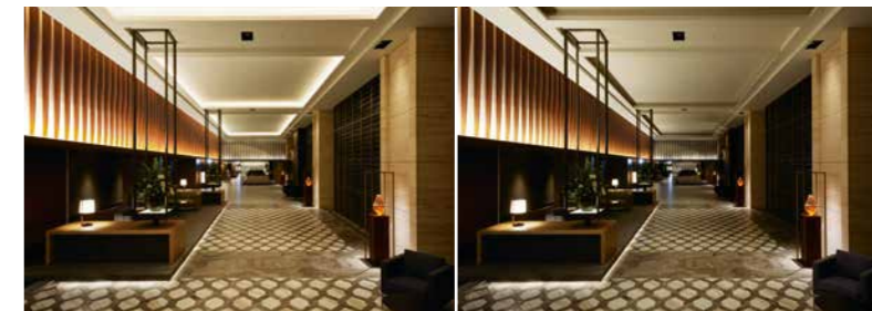
夜間におけるエントランスラウンジの照明環境(左)深夜には天井間接照明を消灯(右)
